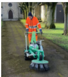
DÉSHÉBAGE / DÉMOUSSAGE DE VOIES
