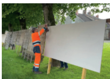
INSTALLATION DES PANNEAUX ÉLECTORAUX
