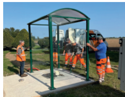
INSTALLATION D'UN ABRI BUS
