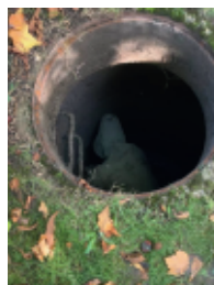
CURAGE DES REGARDS DES EAUX PLUVIALES
