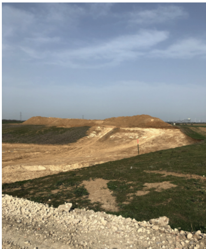
Vue du décapage des parcelles pour préparer le site à recevoir les apports de terre
