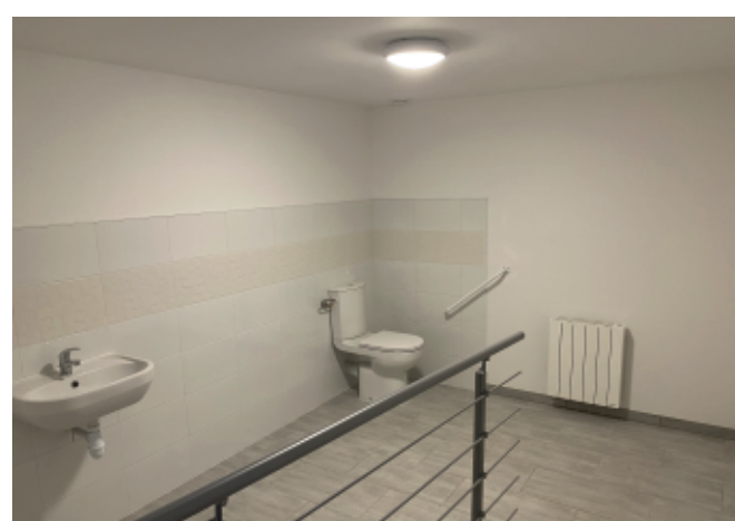
Création de sanitaires PMR Salle Polyvalente de Fains la Folie
