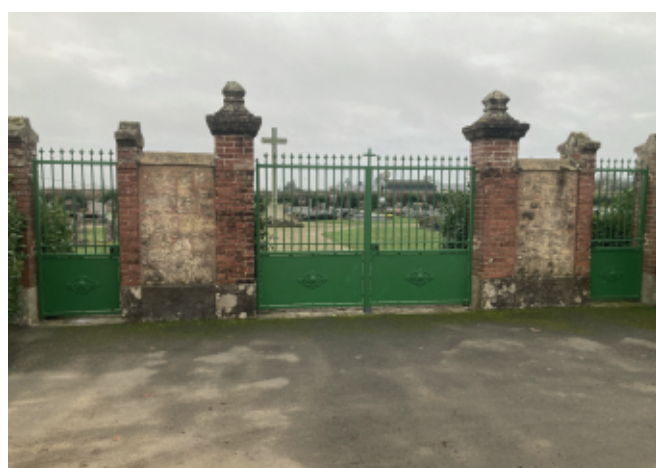
Rénovation du portail et portillons Cimetière de Fains la Folie
