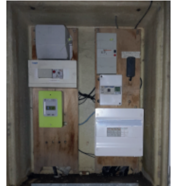
Rénovation armoire électrique éclairage public avec horloge astronomique Montant : 7.210 € HT Subvention : Energie 28 + DSIL - Plan de relance 2022
