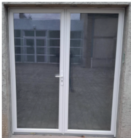
Remplacement de la porte de l'atelier de Baignolet. Montant : 1.935,20 € HT Subvention : FDI + Fonds de concours CCCB
