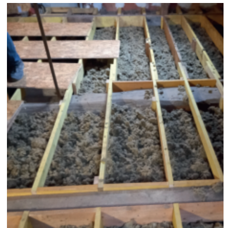
Isolation des combles de la mairie de Viabon. Montant : 6.807,15 € HT Subvention DSIL - Plan de relance 2020
