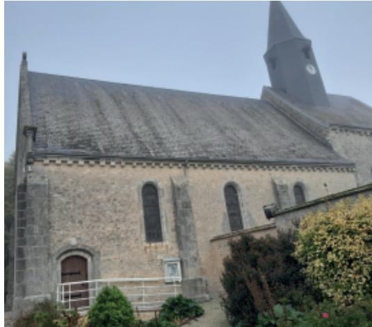
Installation d'une rampe d'accès PMR Montant : 3.641 € HT
