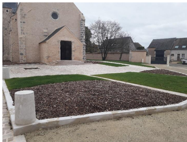
Oinville-Saint-Liphard Aménagement des abords de l'église
