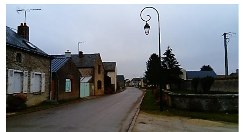
2 ème tranche d'enfouissement à Germignonville
