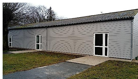
Rénovation de la façade de la salle polyvalente de Viabon
